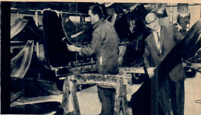
Man tillverkar inte bara stötfångare av plast hos Owens-Corning — till vänster ser vi en plasthuv till tyska VW.
