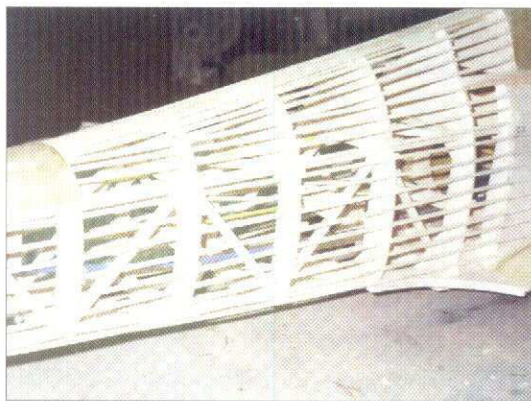
Bakkroppens stringers före dukklädseln
