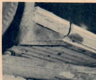
Dörrtrösklarna rostar också gärna både från ovan- och undersidan.
