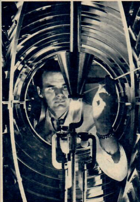
Kontroll av brännare i en AGA fyrinspelare.
