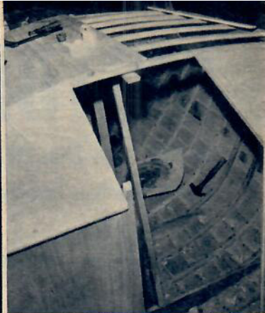
Takbalkarna har en jämnt rundad form för att underlätta avrinningen.
