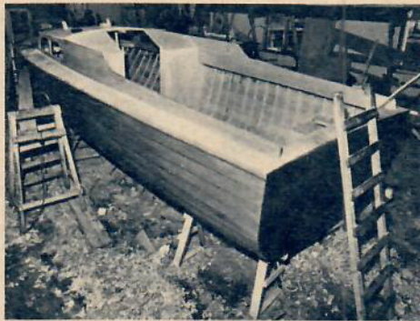
Allt eftersom överbyggnaden färdigställs förtydligas bilden av hur båten kommer att ta sig ut.
