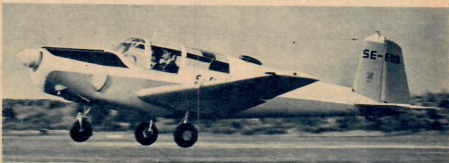
I starten flyter Saab Safir länge och mjukt ut på en luftkudde (ovan). Den uppfällbara överdelen av kabinen gör flygplanet lätt att stiga i och ur (vänster).
