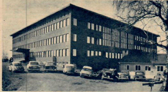
Arkitekt Artur von Schmalensees skapelse är inte särdeles imponerande utifrån. Den består av sex våningar om man räknar källar- och ventilationsvåning. Ovanpå huset kommer ett klocktorn helt i järn att resa sig 29 meter över taket. Vikt 140 ton. Tornet utformas av professor Bror Marklund, Stockholm. (Samtliga fotografier av Gunnar Bergbom.)
