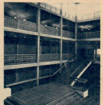
Golven och traporna i stadshus-hallen är av konststen, räckerket av amerikansk furu samt tak, pelare och balkar av obehandlad betong.
