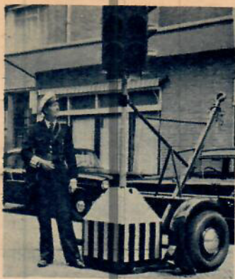
Den här transportabla ljussignalen finns i Amsterdam. Den sätts in vid stockningar och radiodirigeras.
