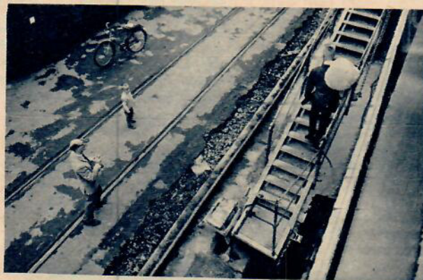
Luckbasen dirigerar från däcket kranen på kajen och ser till att inga stuvare är i vägen när de tunga kroken firas ner i lastrummets djup.
