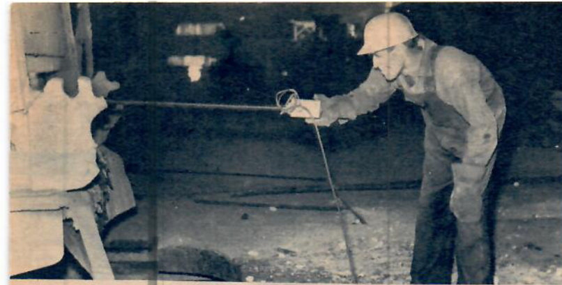
I elektrostälverket finns fyra 30-tonns elektrostälugnar och en 70-tonns. Råvaran utgörs av kallt skrot eller flytande thomasjärn och skrot. Smältaren måste noga följa smältningsförloppet i ugnen. På bilden görs en temperaturavläsning, vilken garanterar att den färdiga produkten är av högsta kvalitet.
