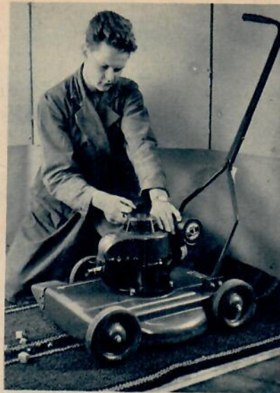
De motordrivna gräsklipparna kör man på en matta beströdd med små aluminiumkuber. Om de visar tendens att leka kulsprutor kan de absolut inte godkännas.
