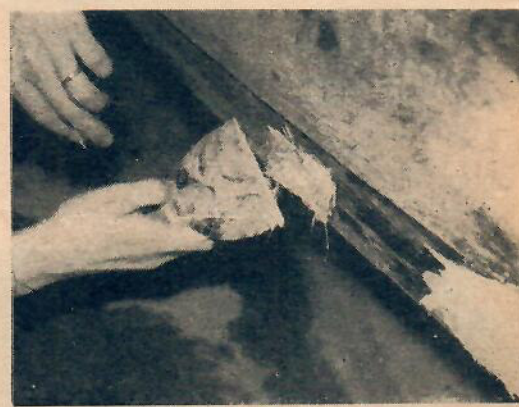
Småbucklor görs plåtrena, spacklas med plast varefter man lägger en plastindräckt glasfibertuss i fördjupningen och spacklar med mer plast.
