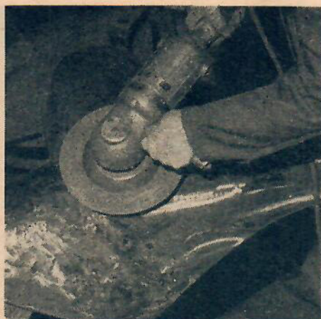
För att plasten skall få fäste måste all rost och gammal färg slipas bort. Detta måste göras noggrant. En slipmaskin är till stor hjälp.
