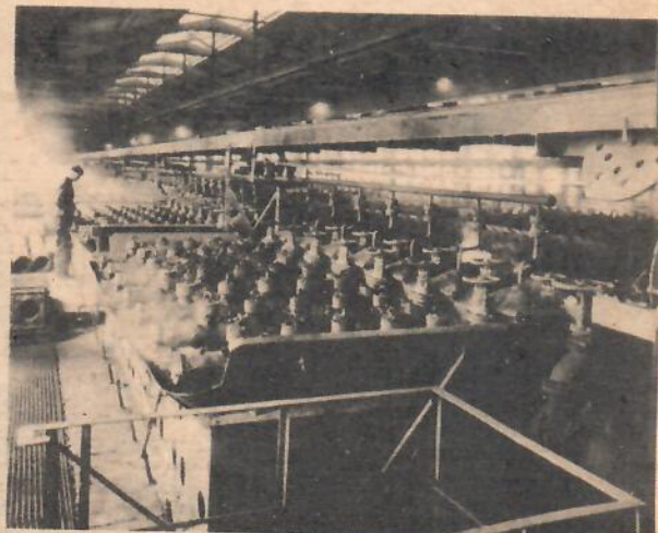
Skiffern fylls på i ugnens övre del och värms på vägen nedåt. Gas och olja avges. Koksen i skiffern ger den värme ugnen fordrar.
