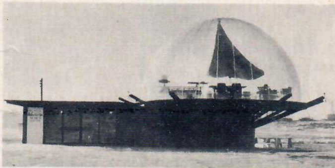
Kupolen på huset är gjord av tunn plast och hålls uppe genom inre övertryck. En luftsluss sörjer för att inte det hela rasar då någon går in.
