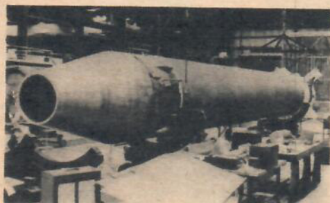
Denna aluminiumtrumma monterad på första stegets noskon inneslöt andra och tredje steget.
