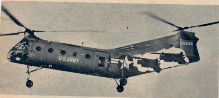
Vertol H-21 (aktuell för marinens del), med två General Electric T-58 gasturbinmotorer på vardera 1.025 hk, ersätter den nuvarande kolvmotorn på 1.425 hk och ger drygt 20 procent större lastförmåga och högre fart.
