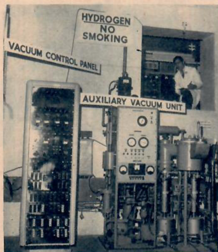
En av vakuumanläggningarna som skall hålla det låga trycket i urladdningsröret. Stora skyltar om rökförbud på grund av vätegaset (hydrogen).
