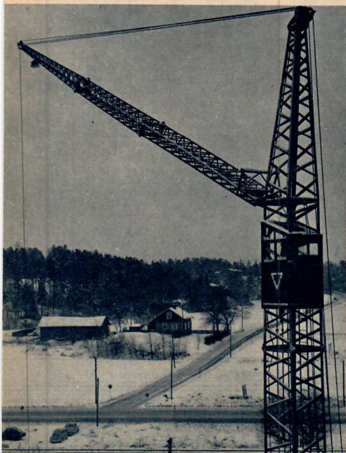
Detta är den tyska krantypen. Kranen löper på räls på marken. Lyftkapaciteten är 1.300 kg vid maximal utliggning på 20 meter.
