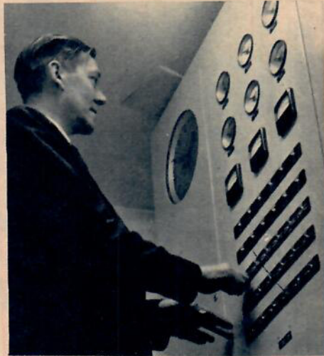
Spårvägens urmakare, Erik Pernils, kontrollerar dagligen de båda synkroniserade huvuduren, som styr alla SS-klockor ovan och under jord.
