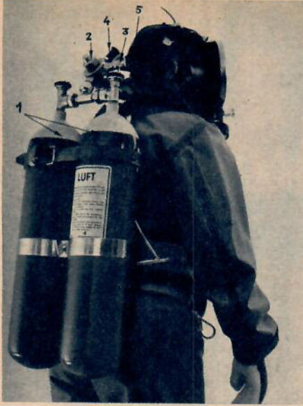
Det här är AGA Divator »ME-1800». Sifferorna betyder: 1) Luftbehållare 2X7 l. 2) Reduceringsventil. 3) Reservluftventil. 4) Slangsockel. 5) Manometerslang. 755:— exkl. ansiktsmask.
