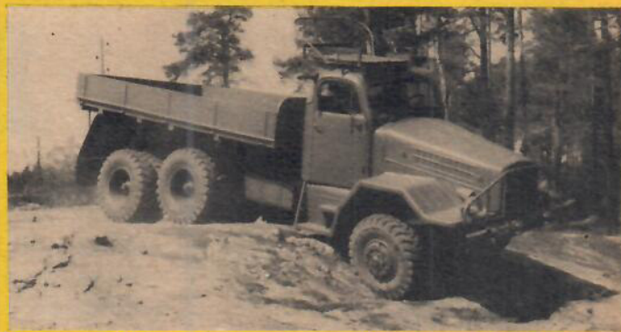
Bakaxlarna på boggin har så pass stor rörelsefrihet som 48 grader. Motor och växellådor har en sammanlagd vikt på två ton. Stabila grejor!
