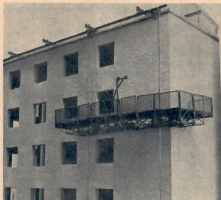
Hissar och lyftkranar — detta är en lämplig hisskonstruktion — används alltmer på byggnadsplatserna. Hantlangarna sparar ryggen.
