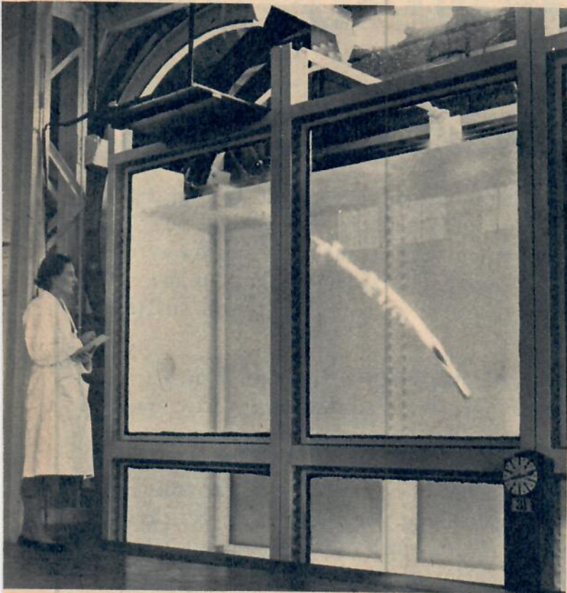
Bilden t. v. visar modellprov med antiubåtrobotar i Teddingtonlaboratoriets vattentank. Bilden ovan: Laboratoriets tankar är så rymliga att man kan använda grodmän vid undersökningarna. Här provas en torped.
