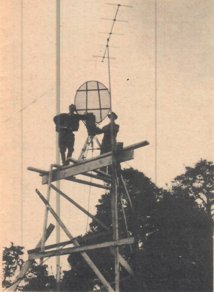
Ett improviserat torn för länkantennen som noggrant riktas mot Tekniska Högskolan. Antennen ovanför tar in Nackasändaren för kontroll (ovan).
