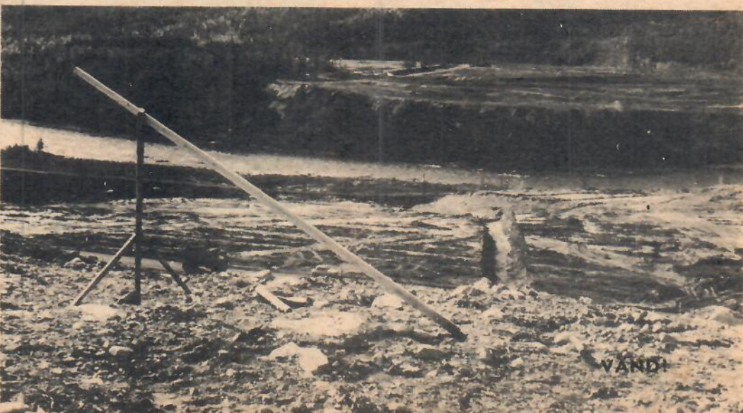
Här skall Messaure-dammen byggas. Bilden är tagen från östra sidan av älven och brädan i förgrunden visar dammens profil. Den blivande dammens överkant går strax under skogsåsens översta del.
