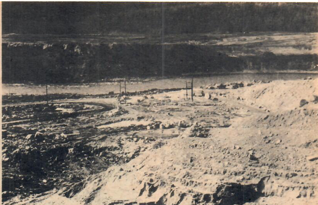
En vy från östra sidan av älven vid Messaure-bygget. I förgrunden området under vilket omloppsdammen sprängs. På andra sidan älven skall huvuddelen av de 15 miljoner kubikmeterna jord tas bort.
