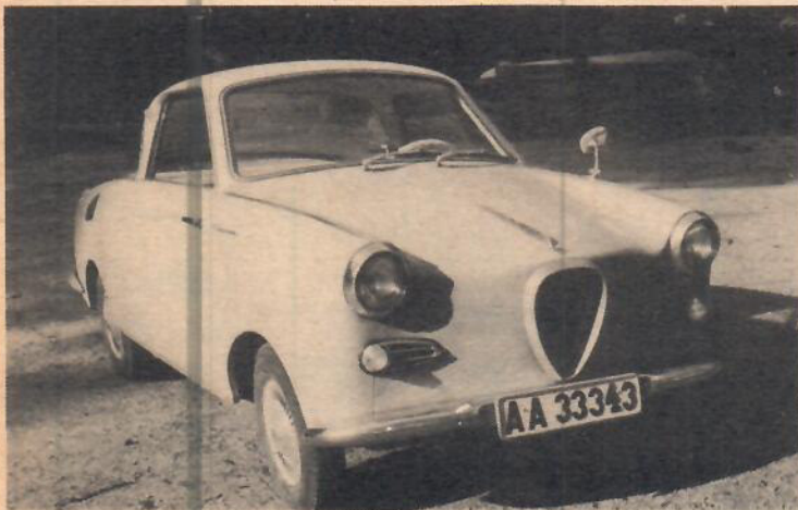
Något som mycket bidrar till att Goggomobil Sportcoupé ser ut som en riktig bil är att svansmotorn kamouflerats genom en kylaratrapp fram.
