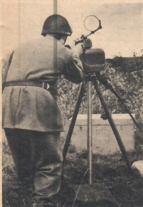
Fledermaus, ett schweiziskt kombinerat radarsikte och centralinstrument som söker och följer målet i avstånd, sido- och höjled automatiskt.
