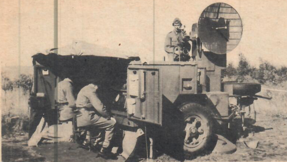
Fledermaus, ett schweiziskt kombinerat radarsikte och centralinstrument som söker och följer målet i avstånd, sido- och höjled automatiskt.
