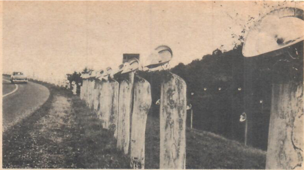
Blixtrifektorerna monterades upp i långa rader för att belysa landskapet runt Horseshoe Curve. Blixterna var en ljusstark typ och rifektorerna platta för att ge stor spridning av ljuset.
