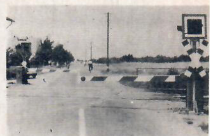
Här är ett tyskt försök att öka säkerheten vid järnvägskorsningar. Den vanliga blinkande ljussignalen kompletteras med halvbommar som spärrar endast körbanan mot korsningen. Genom kontakter i rälsen fälls bommarna när tåg kommer.
