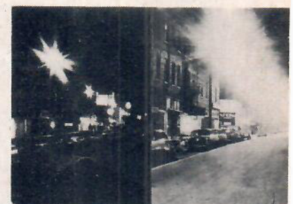
Klagomål på gatubelysningen har på sina håll varit vanliga i Amerika. En övergång från glödlampor till lampor med kvicksilvrigas gav ovanstående goda resultat.
