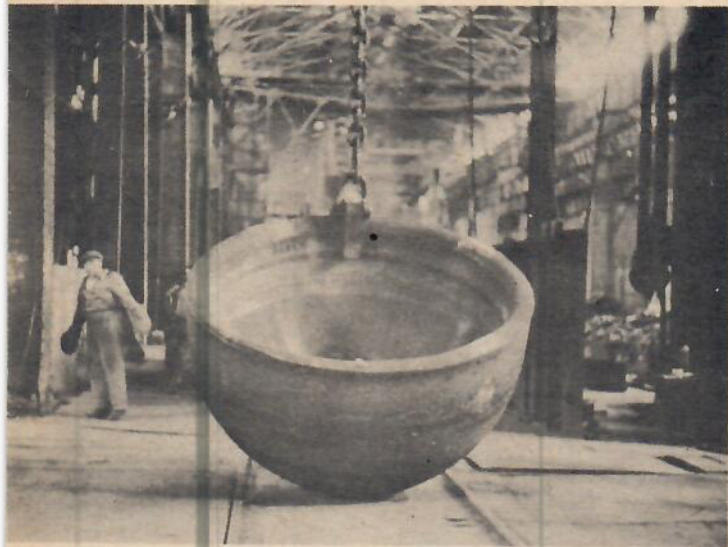
Tvåmeterssfären där observatörerna skall sitta vid dykningarna byggdes vid ett italienskt stålverk. Stålkulan har 9 cm tjocka väggar och väger 10 ton. Den är sammansatt av två halvsfärer. Övan har en väldig stålplatta smitts och nedan har samma platta pressats till halvsfärisk form.
