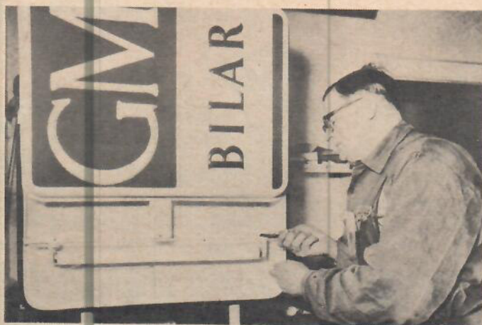
Neonglasblåsare Bernt Widén smälter här på en metallektrod i ena änden av ett neonrör. I den högra handen håller han en gasbrännare.
