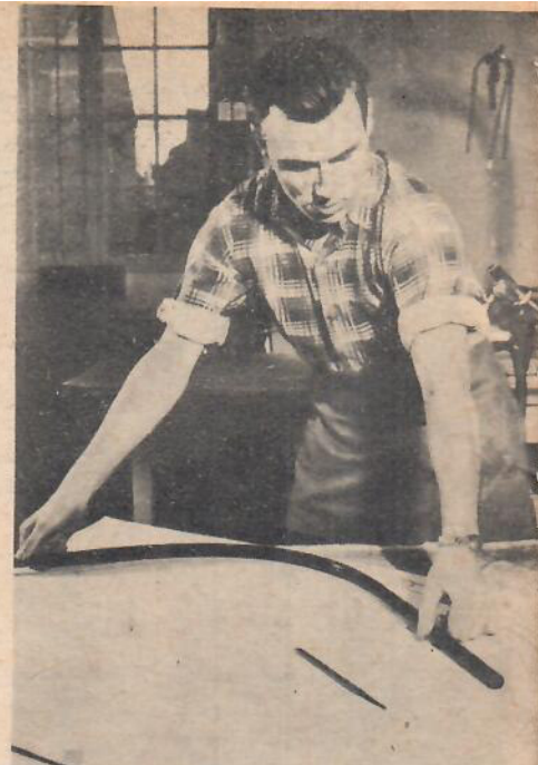
Efter det att rören värmts böckas de efter kartongmallar i full skala. Här böjer neonglasblåsare Bertil Karlsson: ett rör efter mallen.
