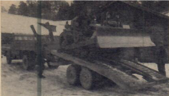
Bandtraktor på gungbräda. När traktorn kör av flaket vippar detta bakåt ned mot marken. När den skall lastas igen backar den upp på flaket som då återgår i transportläge.
