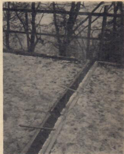
Mot armerad betong fordras kraftigare don. Primaladdningar med riktad sprängverkan klipper av både armering och betong.
