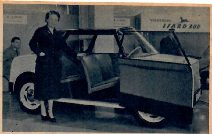
En annan ny schweizisk vagn som visades var originella Sötetta, en fyrehjulig vagn med motorn baktill under baksätet. Vagnen är tre meter lång och har anmärkningsvärt stora dörrar, det går lätt att komma i och ur.
