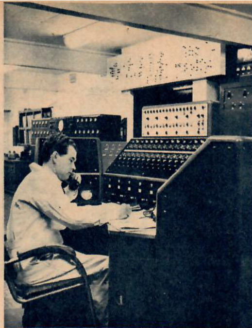
Kontrollrummet med sina många varningsljus och reläer är »hjärnan» i det automatiska leveranssystemet.
