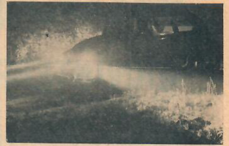
Spiekho heter en ny billykta. Med hjälp av en inbyggd spegel kan föraren dirigera ljuskäglan.
