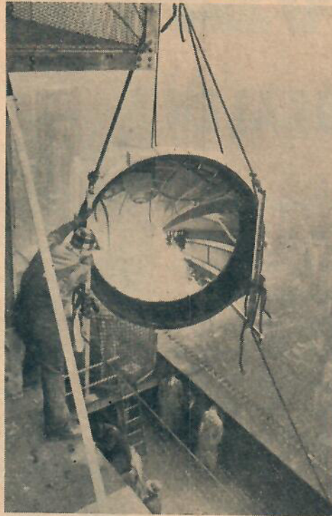
Fyra gigantiska strålkastare skall placeras på New York-skyskrapan Empire State Buildings topp. Tillsammans har de en ljusstyrka på två miljarder normalljus. Här monterar man en av strålkastarna.
