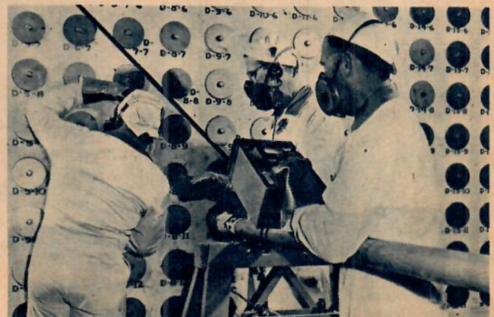
Här avlägsnar man förbrukat uran från Brookhaven-reaktorn i USA. Geigermätare, andningsmasker och skyddshandskar garderar mot strålfaran.
