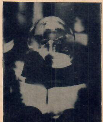
Väsande gasläggar värmer glaset och så smälts foten fast inne i kolven.
