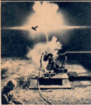
Här en bild av den nya amerikanska sexpipiga automatkanonen Vulcan, som Herr Teve berättade om i nr 21. Vapnet har sex roterande pipor och eldhastigheten är ca 8.000 skott i minuten. Det avses för flygplan, ex. F 104 och F 105.
