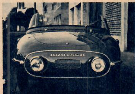
Plastminivagnen Brüttsch finns både som tre- och fyrhjulig. Valfri motorstorlek: 200, 250, 400 cm 3 .
