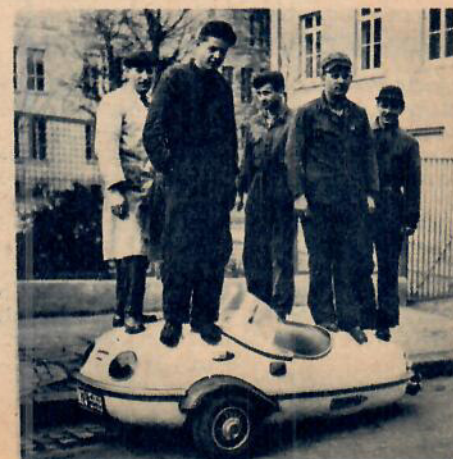
Brüttsch med plastkaross tål åtskilligt. Ända upp till elva fullvuxna karlar kan stå på den!
