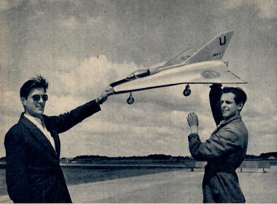
Här är den första Draken, en av de fem readrivna swingline-modeller, som gav värdefulla uppgifter om deltaplanens stabilitet. T. v. ingenjör Gunnar Löw, t. h. Karl Axel Jansson.
