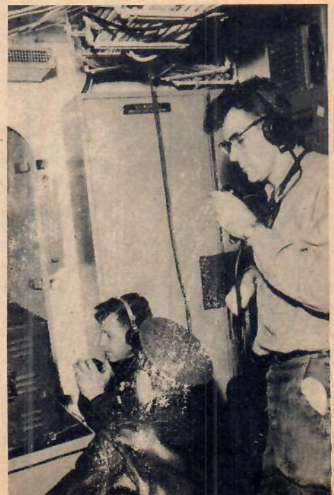
Här kontrolleras en sista gång den omfattande radio- och elektronikutrustning, som användes för att synkronisera blixterna med kamerorna.
