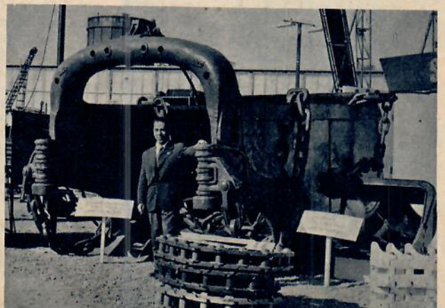
Till de robustare sakerna på planen utanför nya mässhallen hörde en släpskopa av fabrikat Esco. Bjässen väger nästan 10 ton.
