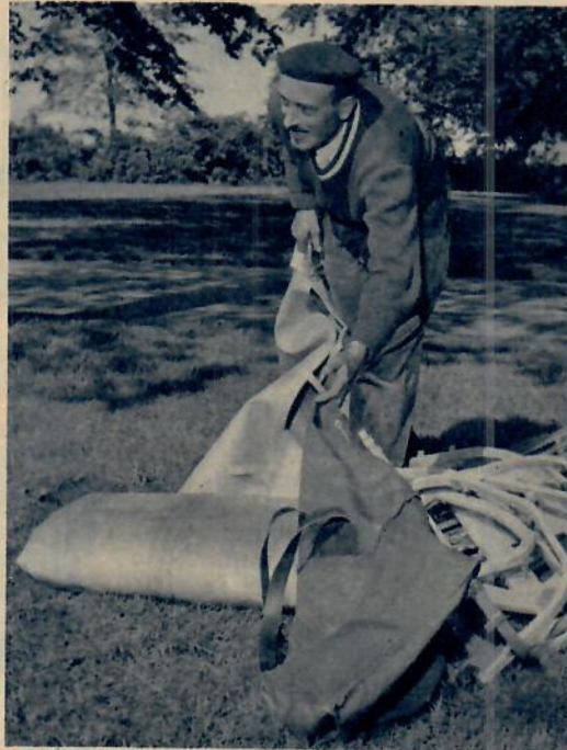
Båten väger inte mer än 65 kg och förvaras hopfäld i fyra särskilda säckar. Med litet vana tar hopsättningen 45 min. och nedmonteringen 20.
