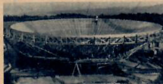
Västtysklands största radioteleskop byggs nu nära Munstereifel. Den paraboliska spegeln mäter 25 m i diameter och väger c:a 20 ton.
