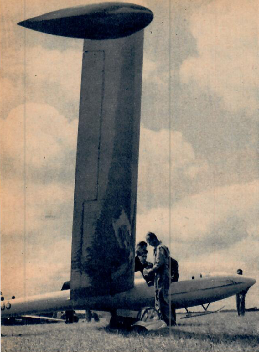
Chock i Sit Yan. Jugoslaviens extrema »Meteor», helt i metall, gav med rätta både flygare och konstruktörer en lätt chock. Vad sägs om ett glidtal av 1:41 vid 90 km/t. Både skida och hjul fälls in i kroppen under flygning. En verklig läckerbit men troligen med astronomiskt pris.
