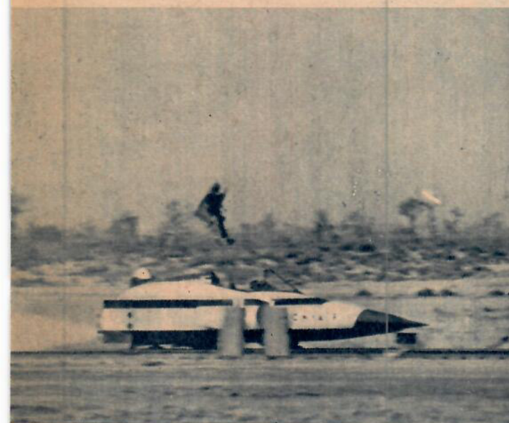
5 Katapultstolen med gummidockan har slungats upp ur sittbrunnen. Snart räcker höjden för att klara även ett överljudplans fena.
