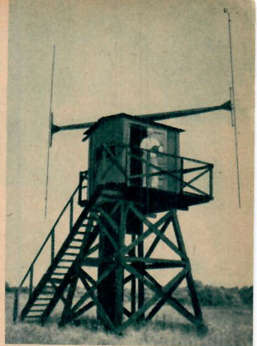
FCC har flera stationära pejlstationer till sitt förtogande i jakten på illegala radiosändare. Denna finns i Laurell i USA.
