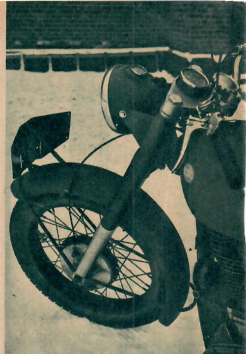
Teleskopgaffeln är betydligt kraftigare än på engelska maskiner och tål hårda törnar.
