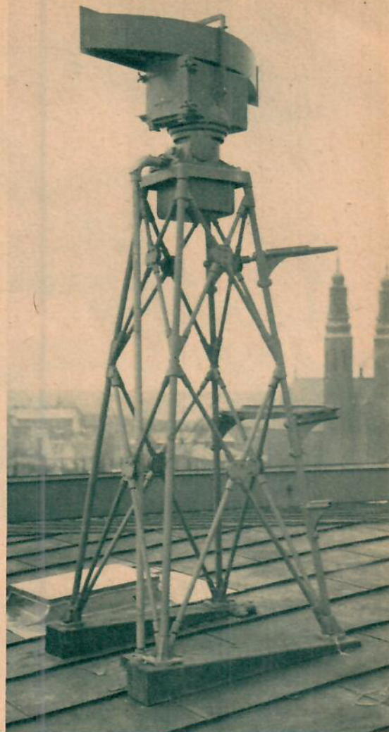
En radarantenn har monterats på taket för att med hjälp av radarskärm och övrig utrustning en våning ned möjliggöra demonstration för blivande radiotelegrafister.
