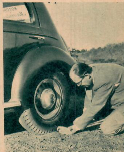
Drivhjulens rullradie mäts av civilingenjör Bertil Björkman. På så sätt får han reda på motorns varvtal vid flera olika hastigheter.
