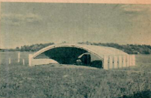
Man har gjort en hel del modellförsök för att få fram olika ljuddämpningsanordningar. Denna valvbyggnad har man tänkt sig över hangarplattformen. Effektivt men ganska dyrbart.
