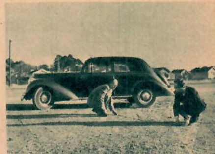
Vändcirkeln får man också fram med mätbandets hjälp och hjulspåren på en sandplan.
