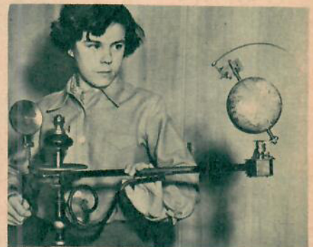
Den astronomiapparat som Gunvor Schelin visar konstruerades på 1800-talet och visar månens och jordens rörelser runt solen.
