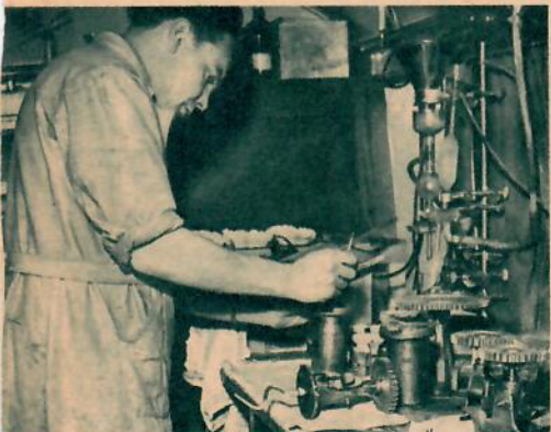
Den mängd betmos — 100 gram — på vilken analysen skall tas får gå igenom varm- och kallbad, där den ligger i hermetiskt tillslutna kopparflaskor. Varmbadet håller 70 grader.
