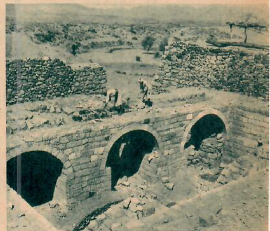
En bensinkällare under byggnad i den arabiska öknen. Efter breddning av startbanan kommer flygplanet att landa på källartaket.
