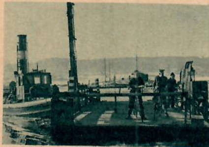
Den nuvarande dragfärjan styrs av en tvåtums stålwire och drivs av en annan wire med hjälp av en elmotor. Vintertid måste man också ha hjälp av en liten bogserbåt.
