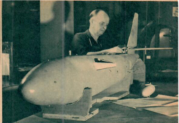
2 Lermodellen har spelat ut sin roll och får lämna plats för en stålmodell i skala 1:50. Här beräknas tyngd- och viktfordelning, exakt.
