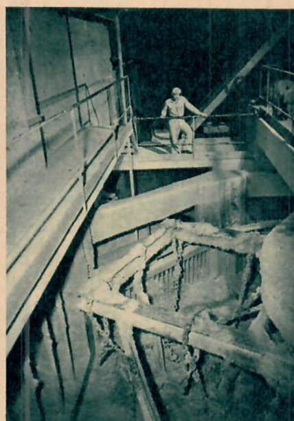
5 En blandning av kalk och vatten blandas med lerslam, sedan kalken renats från onödiga ingredienser. Siktas ytterst nog.
