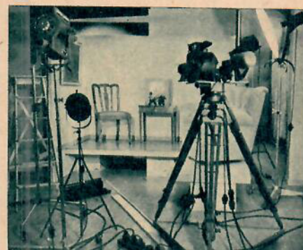
Vid dockfilmning använder regissören och fotografen en specialkonstruerad kamera. Den står på ett stativ och åkningar kan företas såväl i horisontal- som vertikalled.
