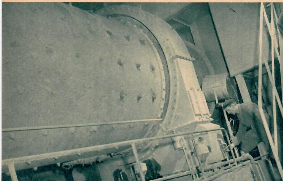
4 I roterande cylindrar finmåles kalken av tusentals stålculor. Ett elektriskt öra (se pilen) reglerar kalktillförseln med utgång från det buller, som malningen åstadkommer. Öväsendet vid malningen är så oerhört kraftigt, att ljudvågorna slår lock för människoörat.
