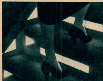
Trappsteg med inbyggd belysning. Det blir inte bara säkrare att gå i trappan utan det är effektfullt och gör sig arkitektoniskt.
