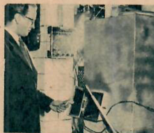
Ingenjör S. Gunnard demonstrerar en varmluftpanna. På väggen en kopplingsplint för vidarebefordran av mätvärden.
