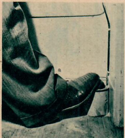
Ett överfallsalarm i form av en trampkontakt finns på många av de större bankerna. På andra sidan disken märks ingenting.
