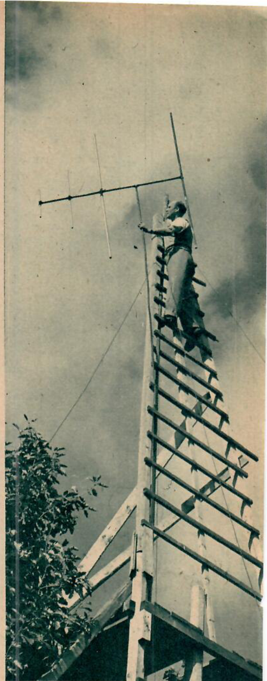
För att kunna ta in de danska programmen perfekt har Nilsson byggt en 13 m:s mast.
