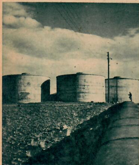
Mitt inne i staden ligger »Reykjaviks Varmvatten Förräds» sju tankar, som tillsammans rymmer 7,5 miljoner liter 85-gradigt vatten.
