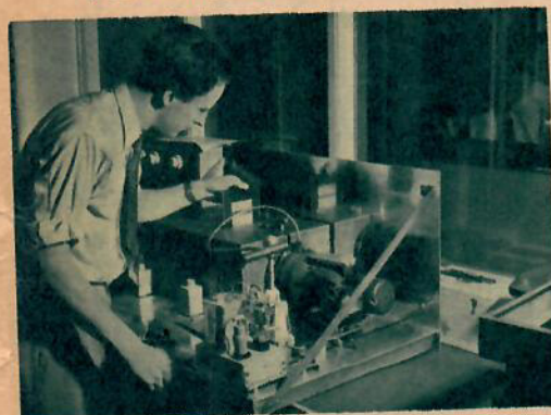
Den elektroniska integralanalysatorn löser besvärliga integralekvationer. På glasplåten i lådan finns en fotografisk funktionsmodell som ljusstrålen från en speciell fotocell får avsöka och omvandla i elektriska spänningar.
