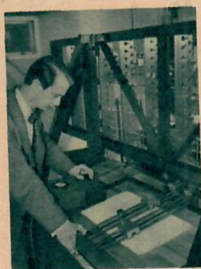
Civilingenjör Björn Lundquist vid ett bord där lösningen automatiskt ritas upp i form av en kurva. »Tankarna» regleras med ratten.
