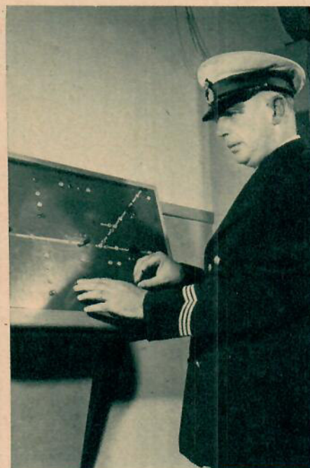
Stationsinspektoren i Arvika, John Hagström, dirigerar numera tågen från manövertavlan och när Anders Larsson på bilden till höger lägger om semaforen med en elegant armrörelse så är det bara för att visa hur det gick till förr. Ljussignaler ersätter semaforen numera.
