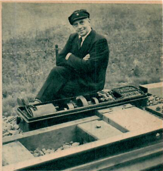
Det är inte länge sedan Anders Larsson fick lägga om växeln i Gilserud med handkraft — i ur och skur. Nu kan han tillåta sig sitta med armarna i kors. Växeln läggs automatiskt.
