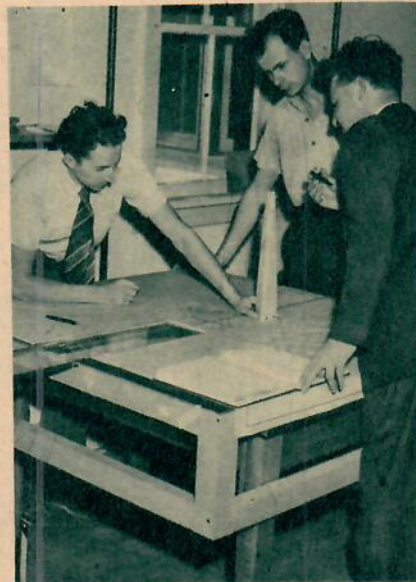
Vetenskapsmännen-observatorerna använder sig av en tredimensionell grafisk metod för att bestämma höjden på radarekon.
