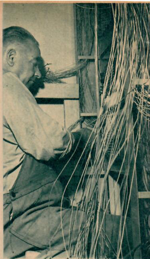
Hotell Malmens väkningscentral under installation. Golte Brunnkvist kopplar ledning.
