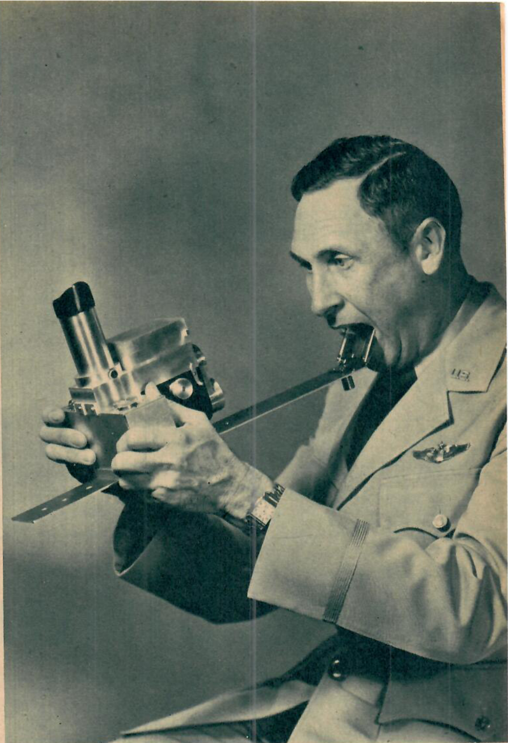
Endoskopkamerans uppfinnare, kapten White, begagnar sin egen skapelse till att fånga insidan av de egna framtänderna på plåten. Metoden är enkel och kan användas av lekmän.
