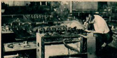
2.500 meter kabel går från ställverket. Det finns 159 reläer och omkopplare. Nätets 220 V transformeras om till 20 V.
