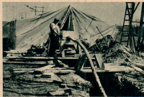
Något hundratal meter på båda sidor om Öresund går kabeln genom jord. Här grävs den ner i den skånska myllan. Den kraftiga luftledningen slutar invid kung Gustaf Adolfs sommarslott, Sofiero.
