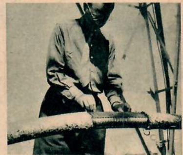
Det behövs kraftiga don till att föra 120.000 volt fram under havsbotten. Den kraftiga isoleringen i kabeln består av många lager med olika material.
