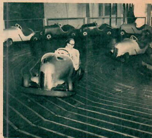
Corsobil heter det här åkdonet. 1½ hk per bil, ström från plus- o. minusskenor i golvet.
