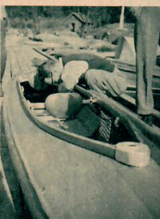
8 För att få riktig stadga åt kanoten blåses några »gummipants» upp. På så vis blir farkosten också absolut osänkbar.
