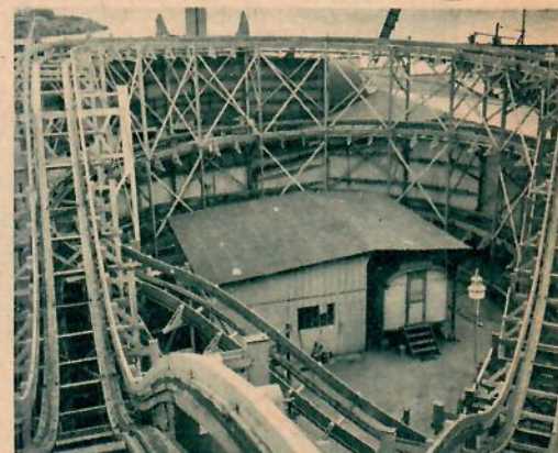
Gröna Lunds bergbana är en imponerande anläggning. Konstruktionen är unik i världen.
