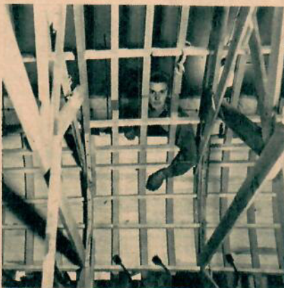
5 Här syns mallarna inifrån med förbindande läktor. Obs. den täta spantningen.
