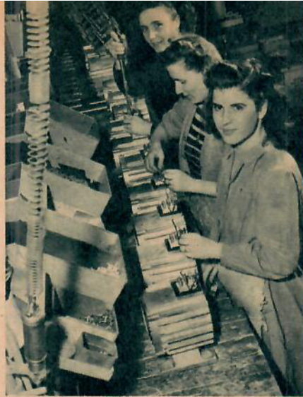
En av faserna i tillverkningen av ASEA:s trefasmotorer — givetvis kortslutna — består i montering av statorruttagen. Tre vackra italienskor utför skickligt kopplingsarbetet.
