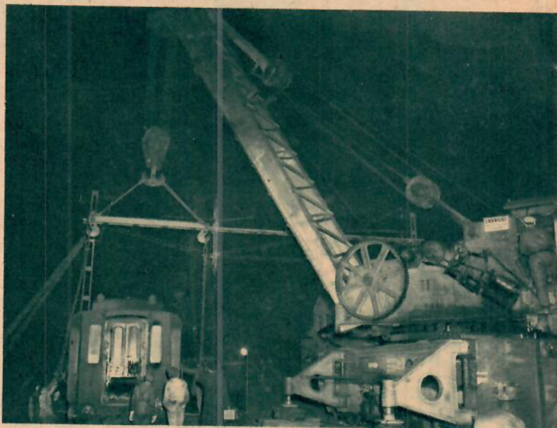
2 Nästa fas i bärgningen består i att de båda lyftkranarna, en i vardera änden, lyfter den havererade vagnen 1 meter upp i luften.
