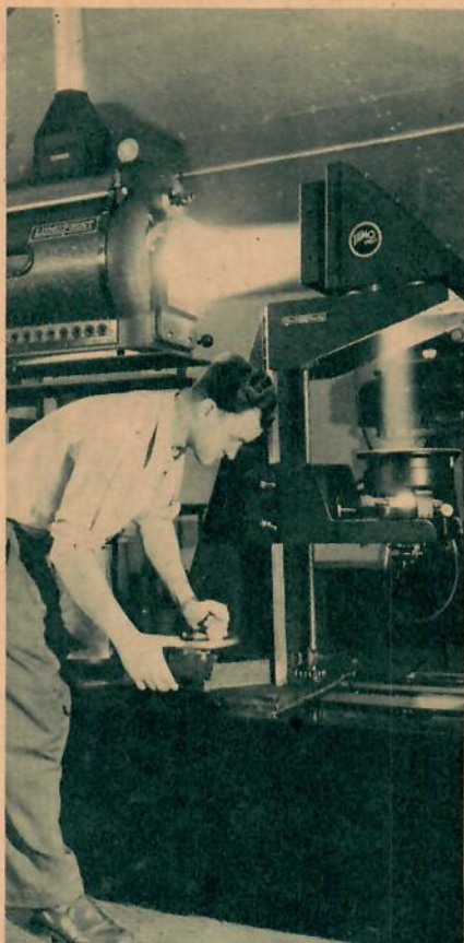
En av projektiionsapparaterna under arbete. Från apparaten kastas bilden på en spegel och sedan genom en diopter ned till plåtslageriverkstaden och på de olika plåtarna.
